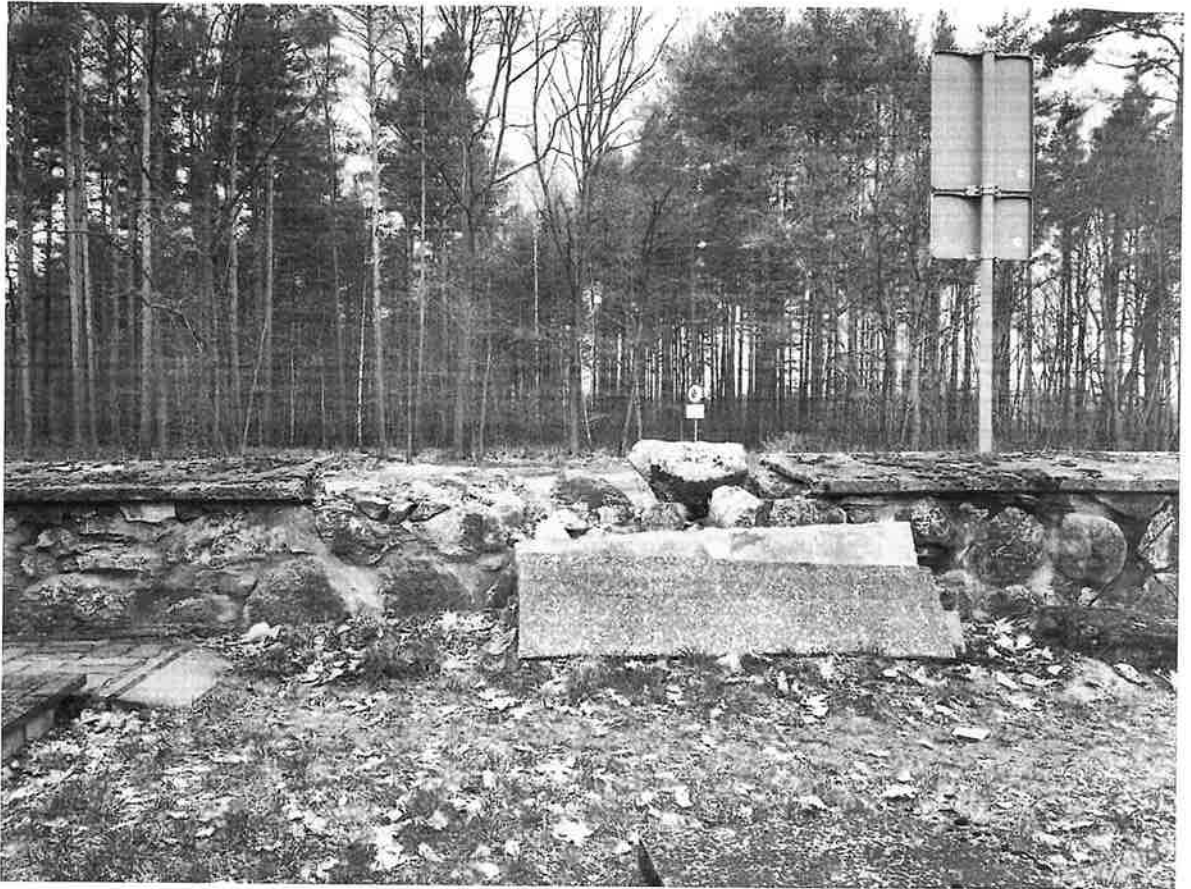
przęsło 28-29 - widok od strony cmentarza
