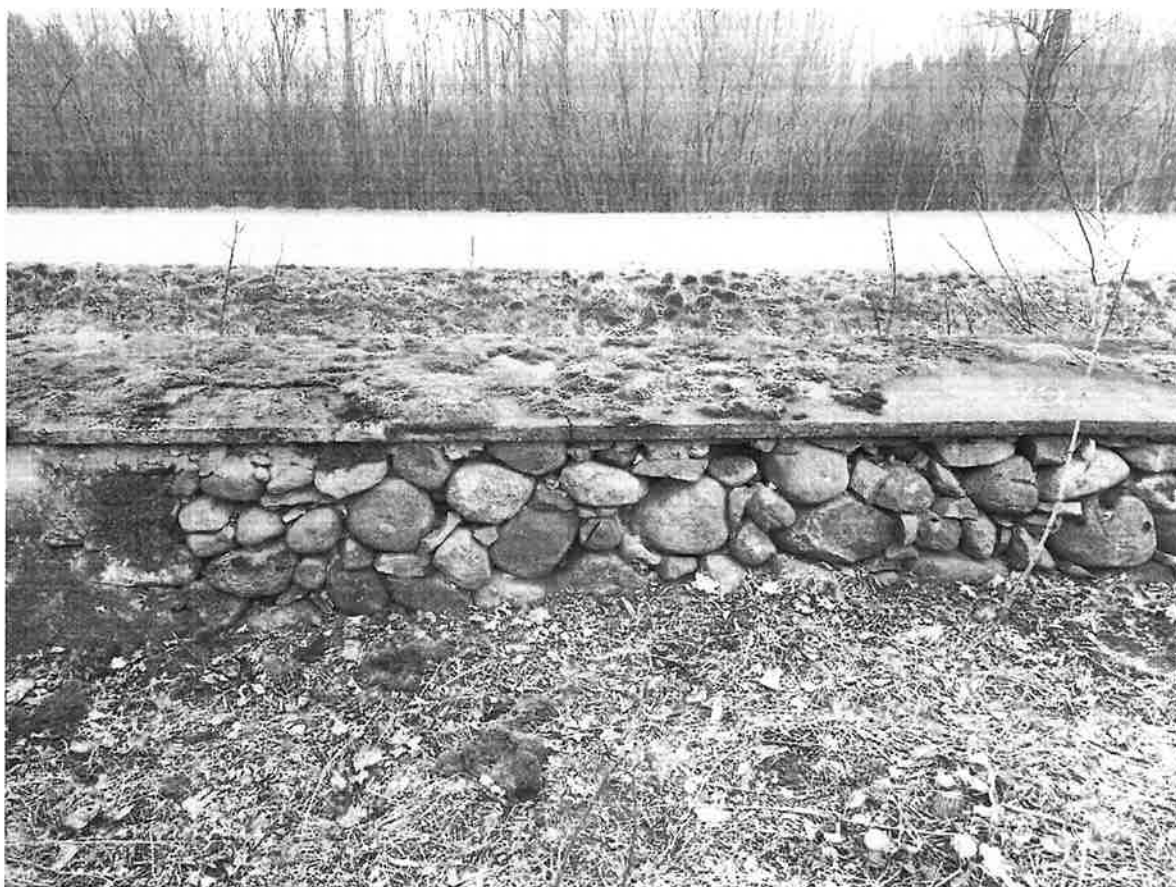
przęsło 82-83 - widok od strony cmentarza
