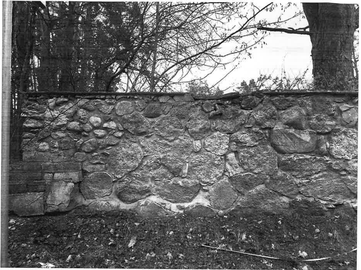
przęsto 0-1 - widok od strony ulicy
