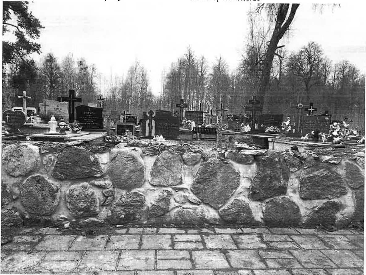
przęsło 35-36 - widok od strony ulicy
