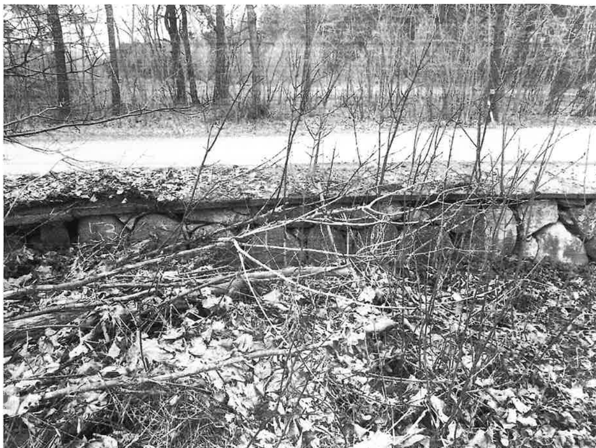
przęsło 53-54 - widok od strony cmentarza
